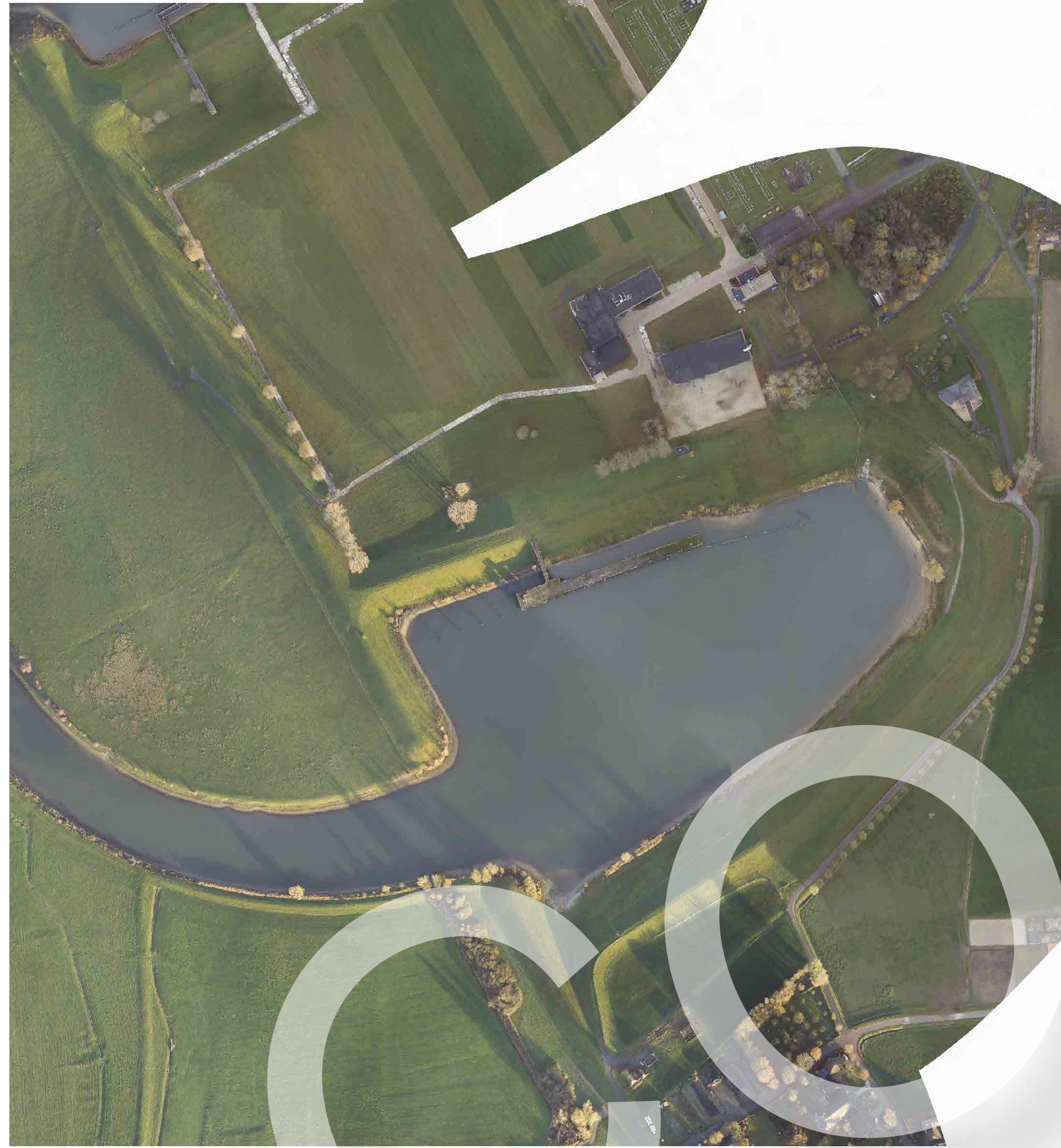
Luchtfoto huidige situatie
