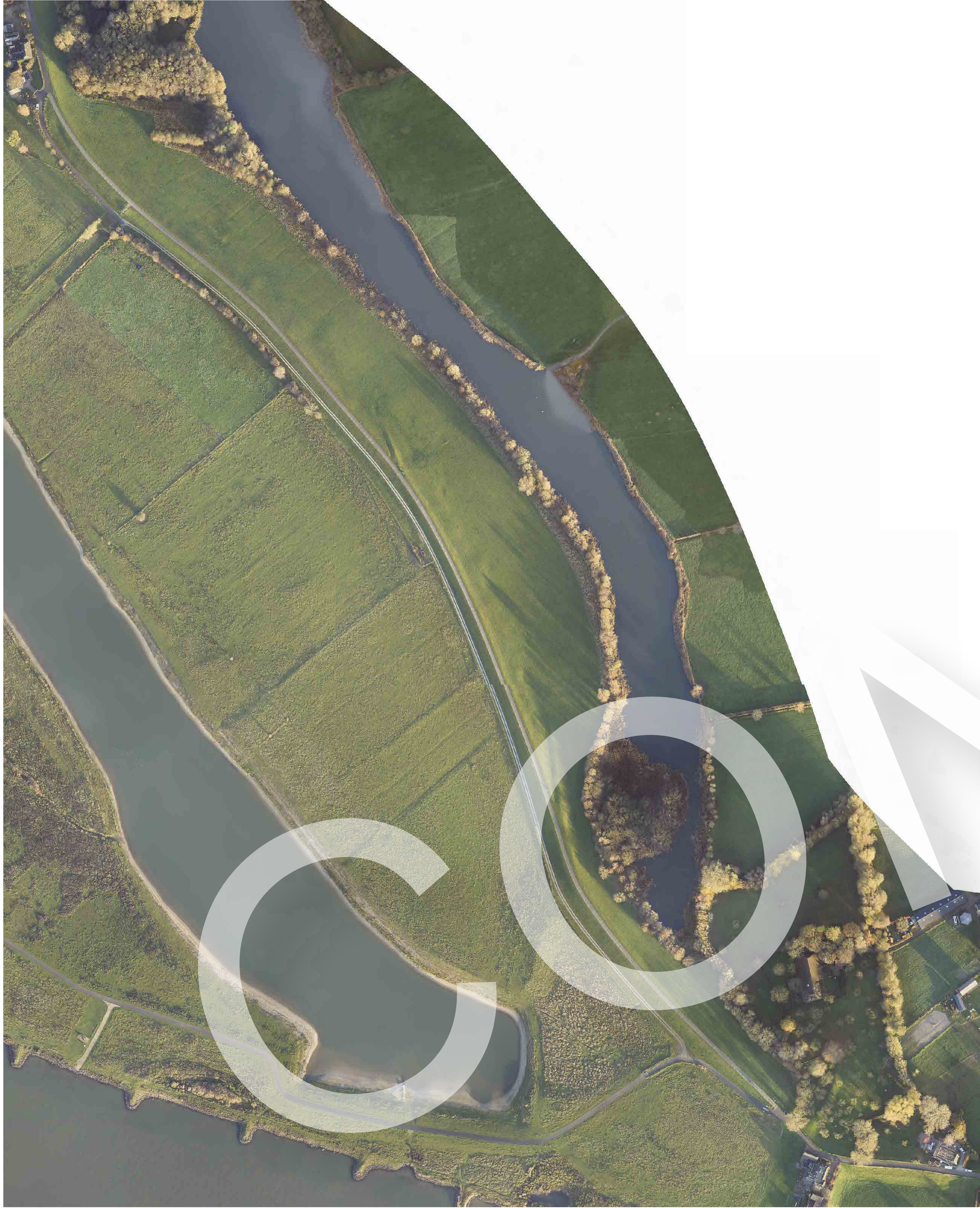
Luchtfoto huidige situatie
