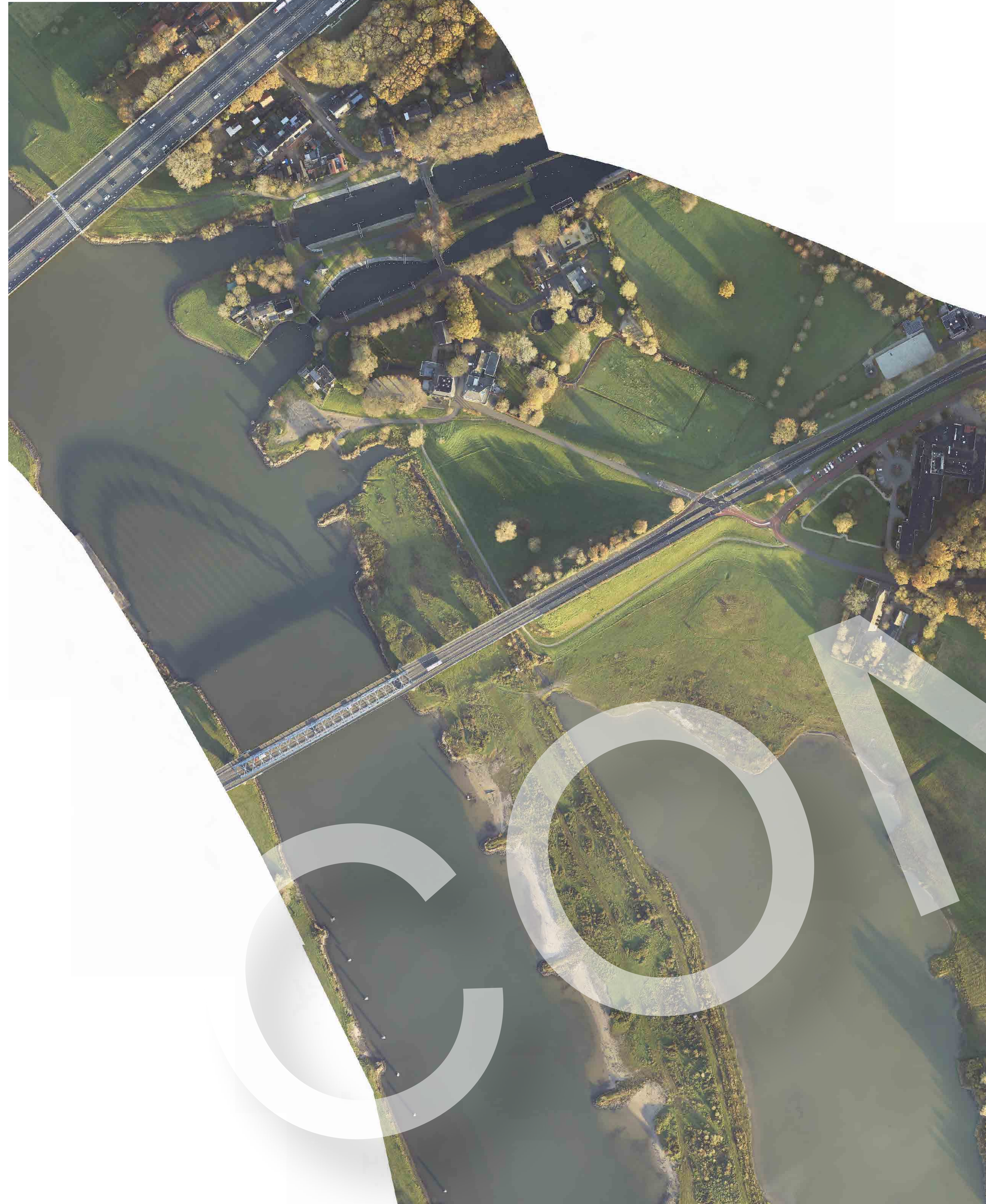
Luchtfoto huidige situatie
